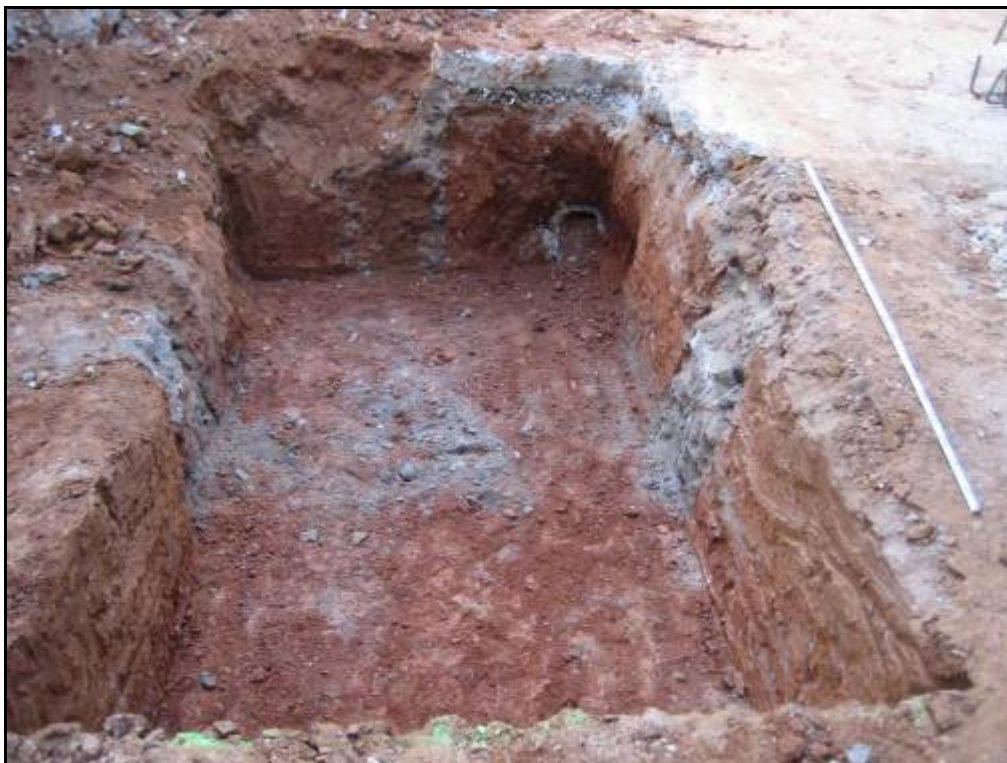
Fotografia 11. Detall de la sabata 2 un cop realitzat el buidatge de terres.
