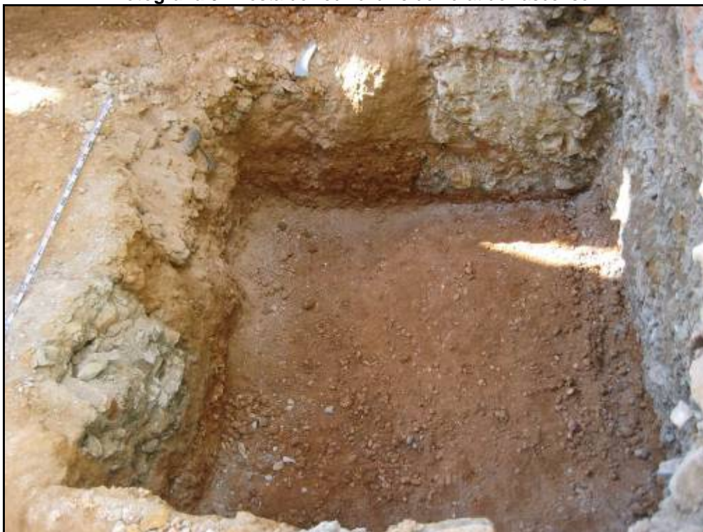
Fotografia 6. El forat de l'ascensor un cop fet el buidatge de terres.
