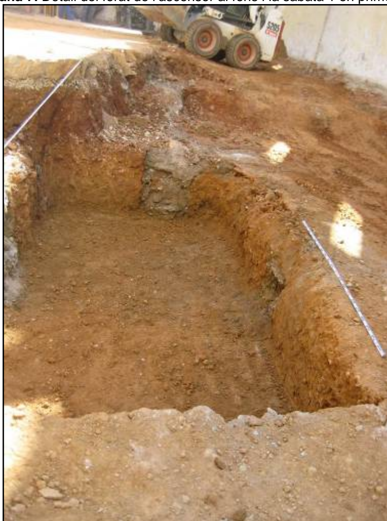
Fotografia 8. Detall de la sabata 1 un cop realitzat el buidatge de terres.
