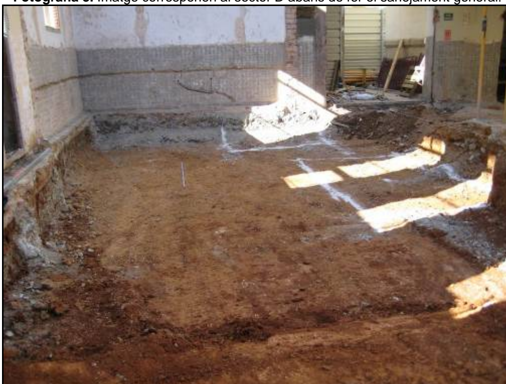
Fotografia 4. Sector C després de fer el sanejament de terres.
