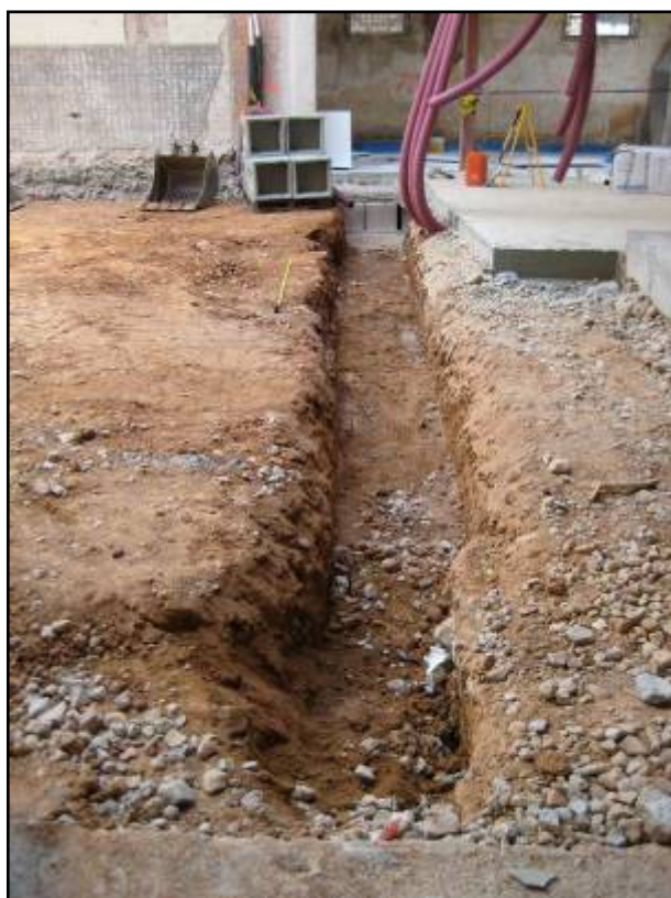
Fotografia 28. Detall de la rasa Q.
