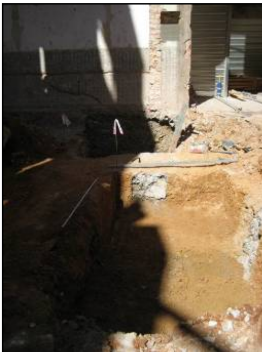
Fotografia 7. Detall del forat de l'ascensor al fons i la sabata 1 en primer terme.
