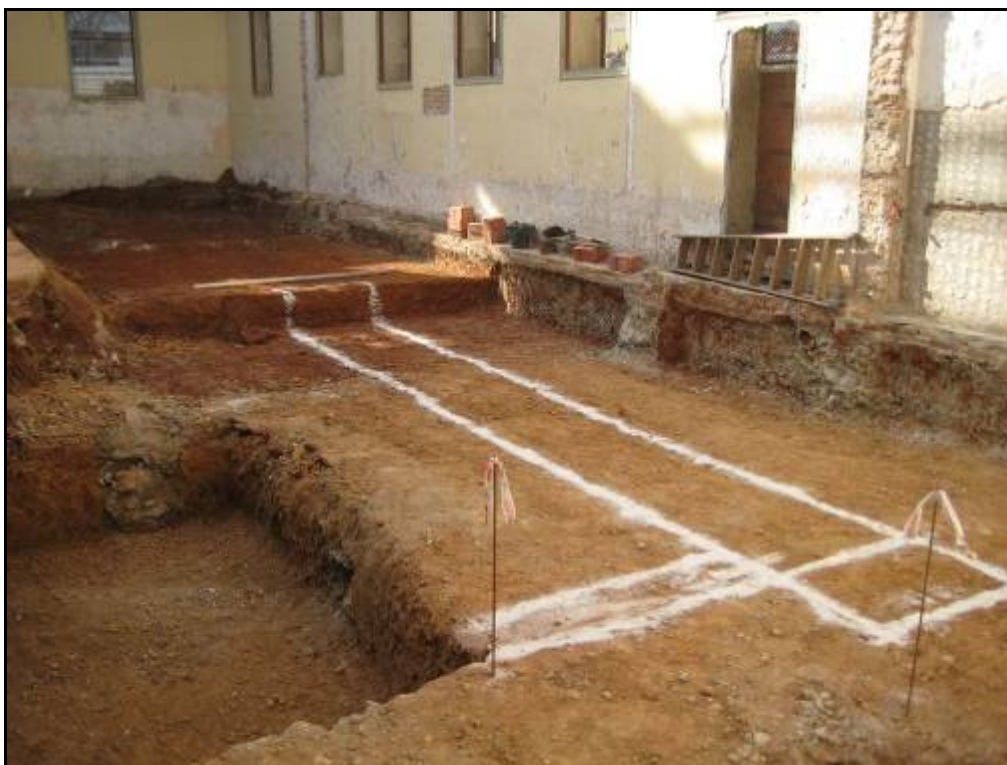
Fotografia 9. Plantejament de la riosta 2.
