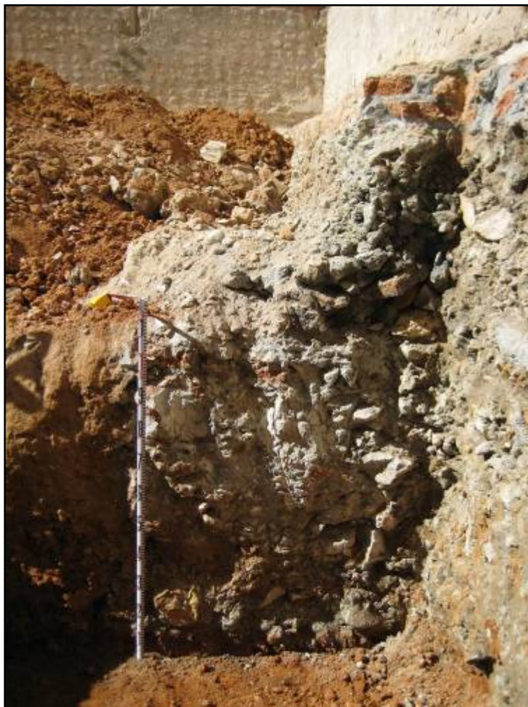
Fotografia 5. Riosta de l'edifici dins del forat de l'ascensor.
